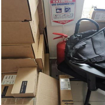
Fuente propia: Foto piso 6
