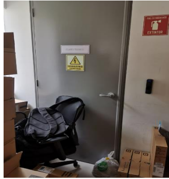
Fuente propia: Foto piso 6
