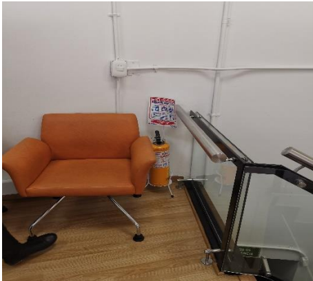
Fuente propia: Foto extintor obstruido por una silla piso 22, Fuente propia: Foto cuarto técnico piso 20
