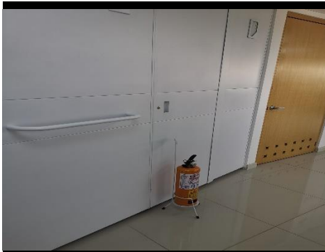
Fuente propia: Foto extintor sin señalización piso 7
